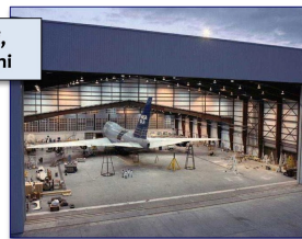
es. hangar di manutenzione aerei
